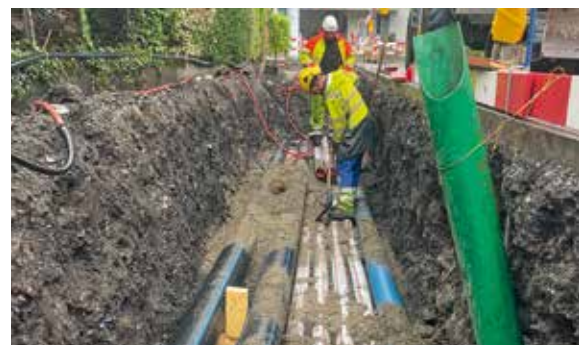
EVS-, Elektro- und Wasserrohre im gleichen Graben
