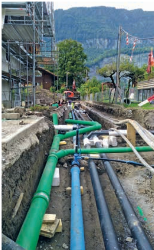
Lengenacherweg mit den neuen Werkleitungen
