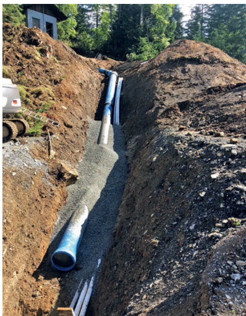
Verlegung der Leitung unterhalb Bidmi
