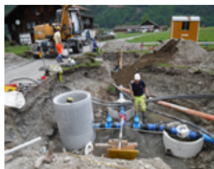
Einbau Schieberspiel mit Zähler in Unterbach
