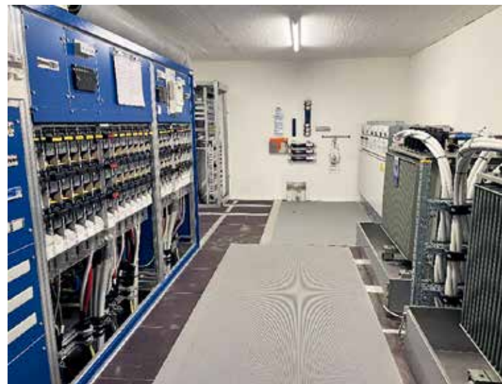
Sanierung TS Alpbach
