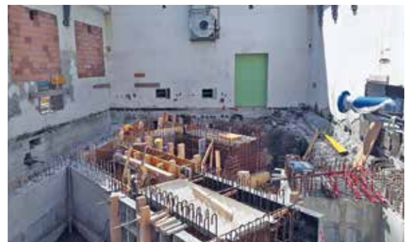
Zentrale MII / Unterwasserkisten und Unterwasserableitung im Bau
