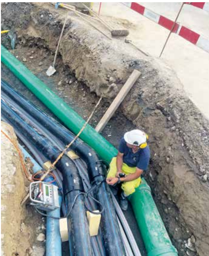
Verschnaupause des Brunnenmeisters beim «PE Schweißen», EVS Rohre Sandmatten
