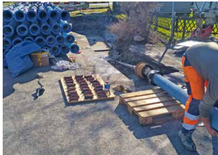
Vorbereitete Einzugsrohre, Unterstossung Balmbrücke
