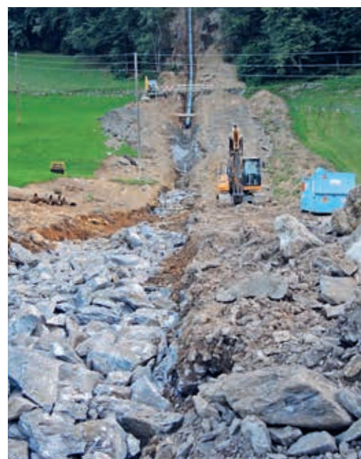
Baustelle im «Mätteli» Blick gegen Sandhubel
